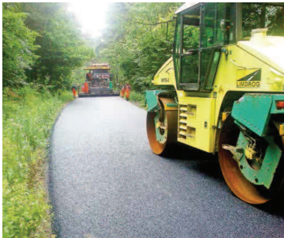
Asfalty modyfikowane MODBIT w nawierzchni na drodze pozamiejskiej
