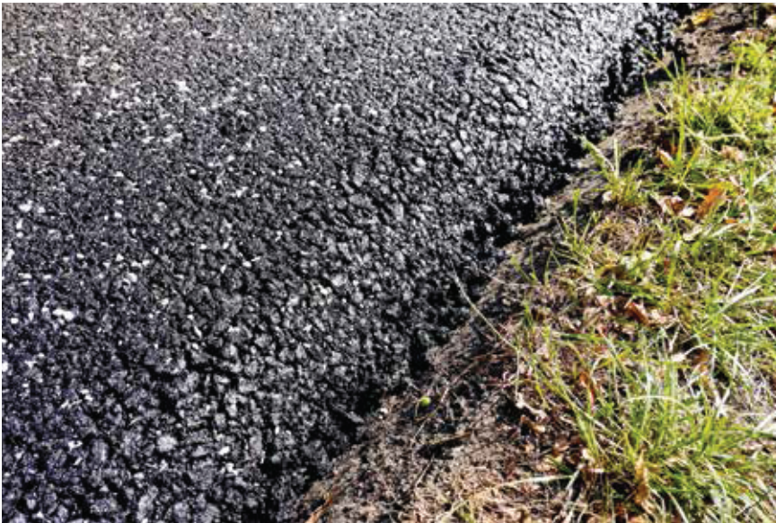
Nawierzchnia asfaltowa SMA 16 JENA
