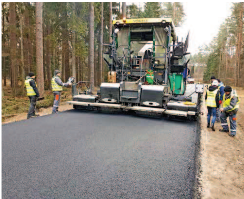
Asfalt 50/70 WMA na drodze powiatowej w lesie, budowanej w listopadzie przy temperaturze powietrza 0 st.C
