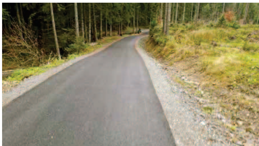
Asfalt na drodze leśnej o dużym spadku podłużnym, po której odbywa się transport drewna. Nadleśnictwo Ujsoły
