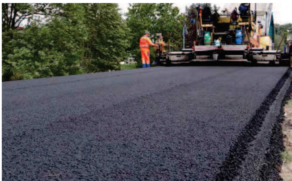
SMA JENA Jednowarstwowa Nawierzchnia Asfaltowa z asfaltem 50/70 z LOTOS Asfalt zastosowana przy przebudowie drogi samorządowej w Grobelnie
