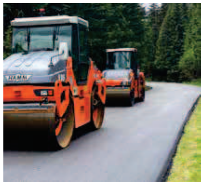
Proekologiczne zastosowanie w warstwie ścieralnej tatrzańskiej drogi gotowego asfaltu 50/70 WMA (Warm Mix Asphalt) do technologii „na ciepło”
