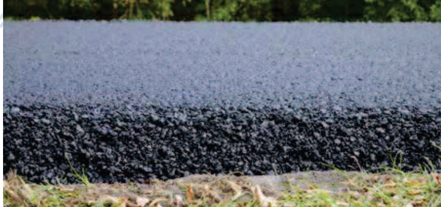
Ekologiczna nawierzchnia asfaltowa SMA16 JENA z asfaltem modyfikowanym na bardzo obciążonych drogach Dolnego Śląska
